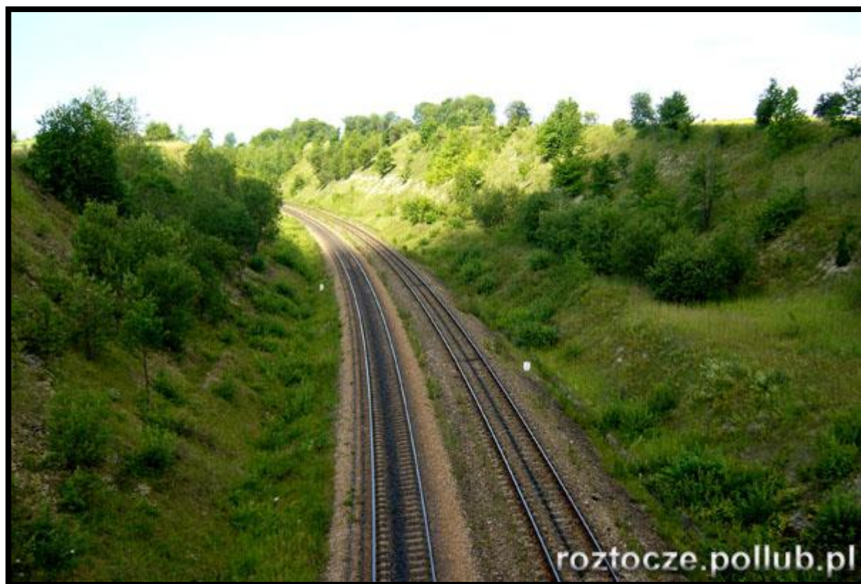
Kolejowy „kanion” w Szozdach
